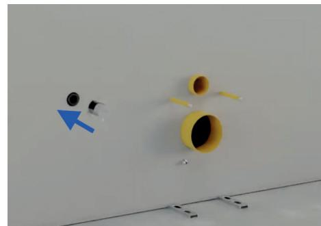
Privedťte teplú a studenú vodu k podomietkovej zmiešavacej batérii (batériu umiestnite v blízkosti WC). Vývod zmiešanej vody z batérie umiestnite podľa obrázka v mieste pod odpadovou rúrou. Ukončite ho „nástenkou“ so závitom 3/8“.
